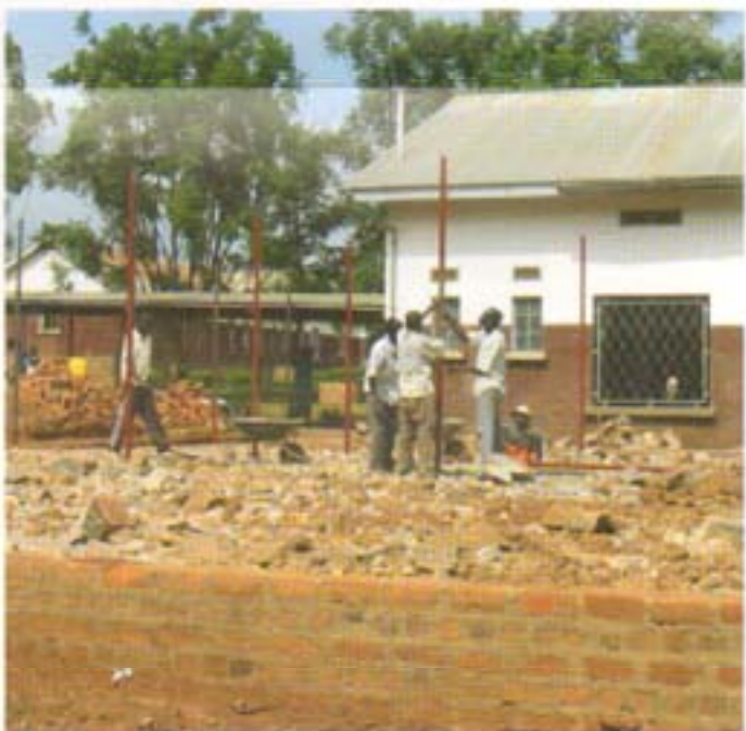
Iniziano i lavori di costruzione
